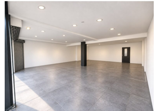
Projection 3D - Local dégagé et remis en état
